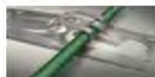
Elemento in PVC per la connessione del cavo al sottofondo
